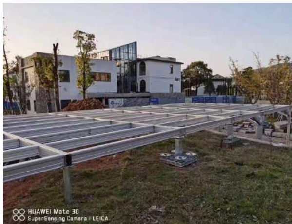
Imagen de sistema de cimentación HOMMI previo a la colocación de paneles.
